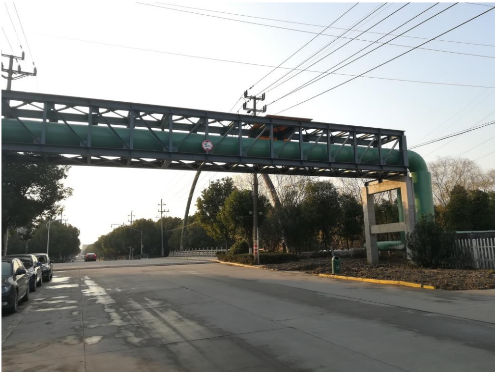
图 6 管网上跨公路走向
