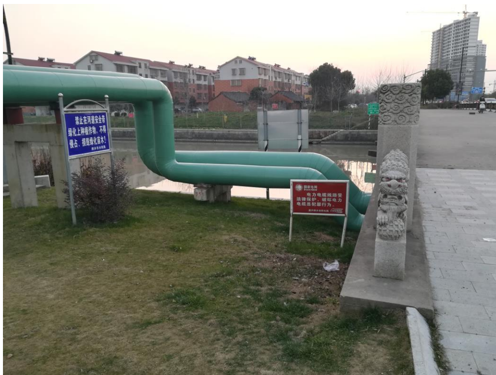
图7 管网桥下架管走向
